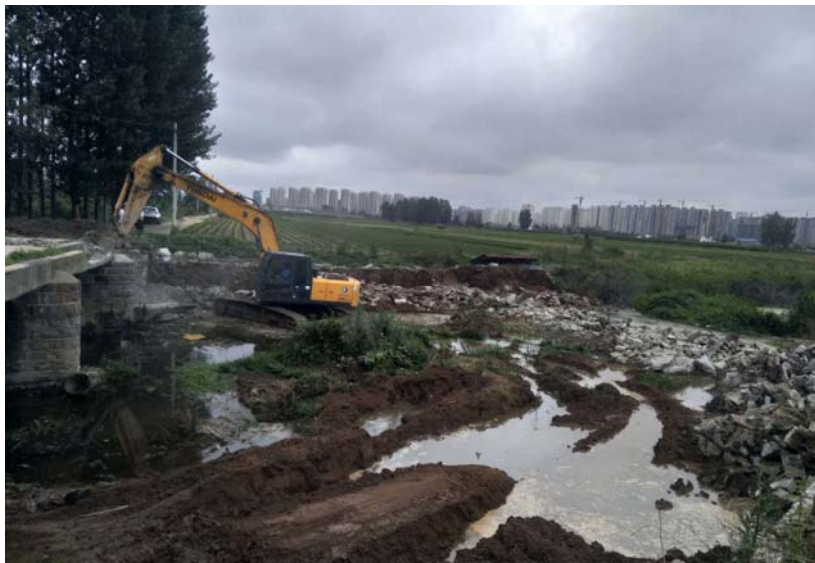
7月7日进展情况（拆除陡沟桥）
