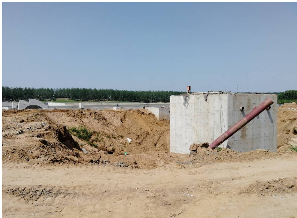
8 月 20 日进展情况 ( 橡胶坝主体工程 7 月已完工，正在进行泵房建设 )
