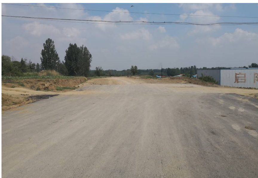
( 钟华山段北向 ) 7 月 20 日进展情况 ( 属防洪堤 , 8 月暂停施工 )
