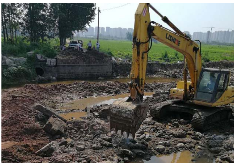
7月20日进展情况（新陡沟桥基础开挖）
