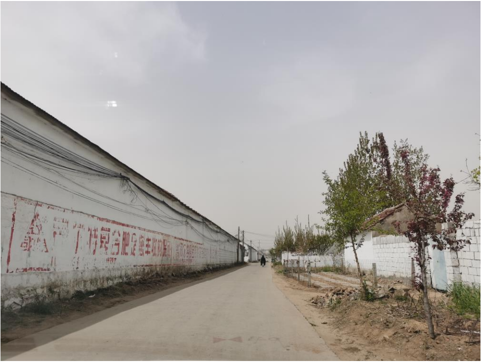
玉山镇部分村道实景图
